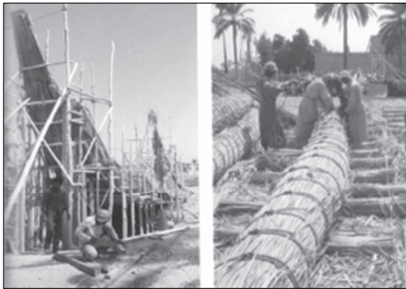
تصویر ۲۲. ساخت کشتی با استفاده از نی و برگ نخل در عراق امروزی، سنتی که از هزاران سال پیش از بین النهرین و سواحل خلیج فارس رواج داشته است. (مأخذ: نگارنده)
